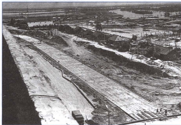
В поселке Нефтеюганск прокладывается первая бетонная дорога рядом с временным жильем геологов. 1963 год.
