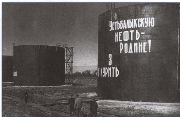
На нефтяном промысле Усть-Балыкского месторождения. 1964 год.
