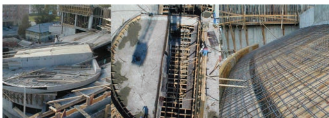
Строительство здания Музея геологии, нефти и газа. Ханты-Мансийск, 2001–2002 годы
