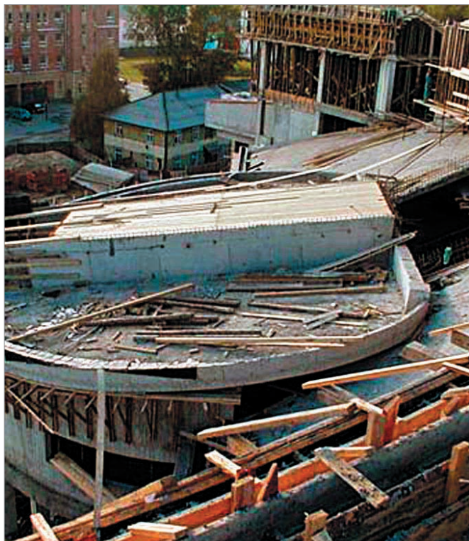
Строительство здания Музея геологии, нефти и газа. Ханты-Мансийск, 2001 – 2002 годы
