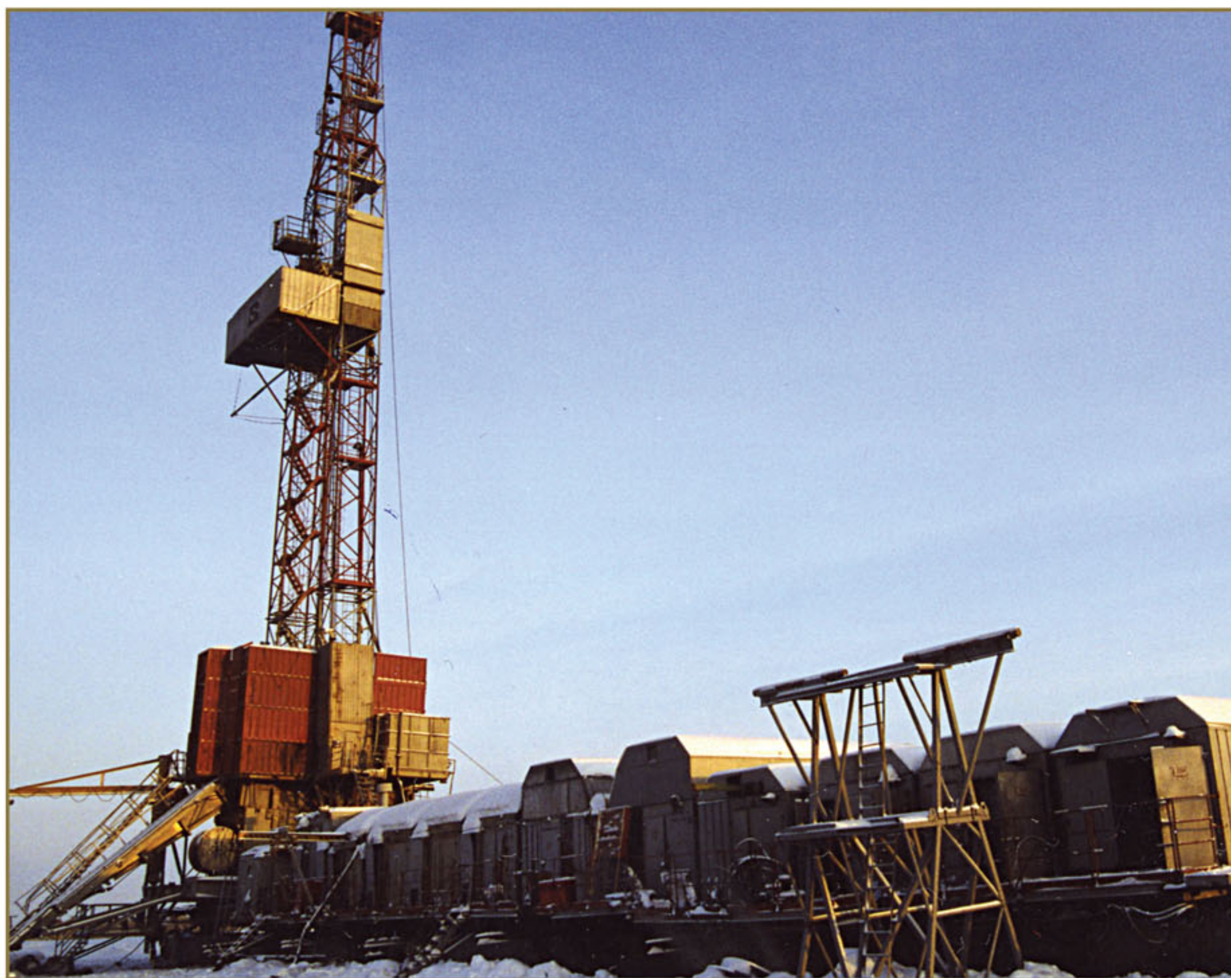
Новые буровые установки на промыслах Сургута
