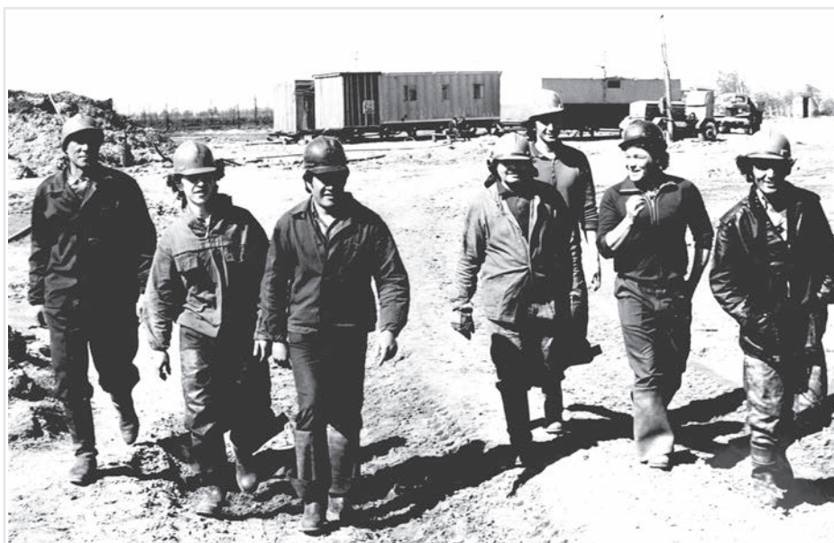
♦ Бригада Семёна Урусова. Трехозерная площадь Шаимского нефтяного месторождения. 1961 г. Фото В. Ахломова. МГНГ-НВ-4905/13
