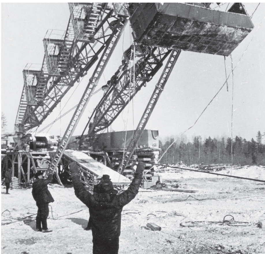
♦ Установка буровой вышки на Мегионском месторождении. МГНГ-ОФ-3891
