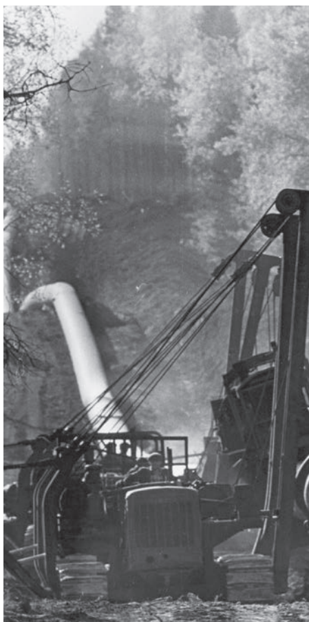
♦ Трасса нефтепровода. Усть - Балык - Омск. 1965. МГНГ-ОФ-4700
